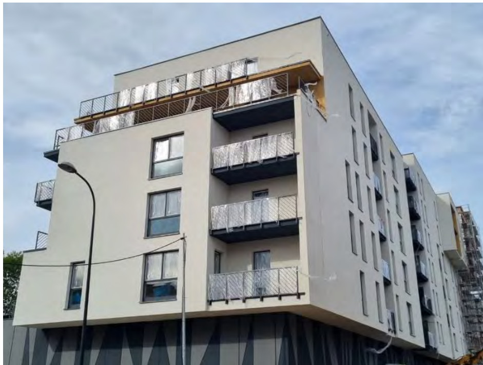
Źródło: Emitent, stan budowy – październik 2023 roku
